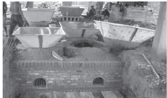
Fig. 5. Fotografía de la hornilla tradicional, muestra la forma en la cual se ubican los calderos sobre la hornilla.
